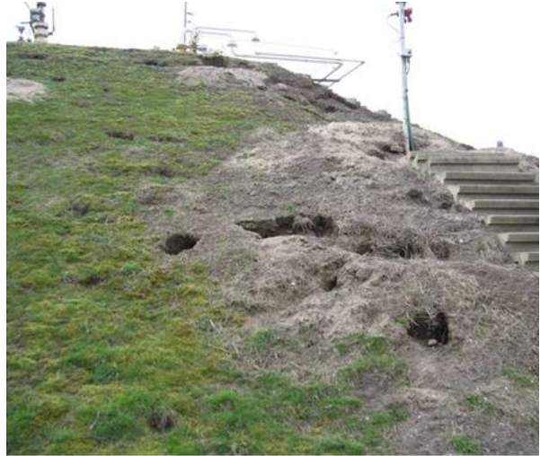
Afbeelding 8: Grote hoeveelheid konijnenholen in tankdijklichaam (tankwal) en detailopname van konijnengegraaf, Rotterdams havengebied
