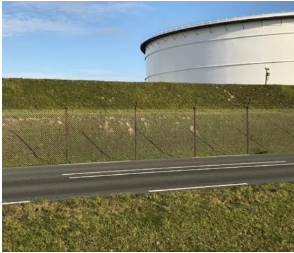
Afbeelding 8: Grote hoeveelheid konijnenholen in tankdijklichaam (tankwal) en detailopname van konijnengegraaf, Rotterdams havengebied
