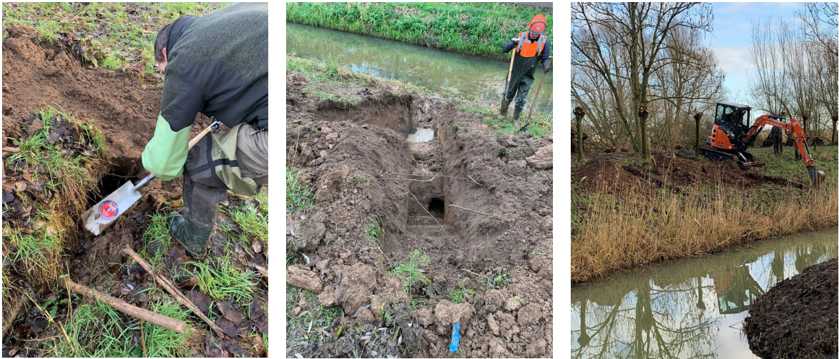
Afbeelding 2. Het blootleggen van een gangenstelsel (Foto's J. van der Baan, Waterschap Hollandse Delta, 2023)
