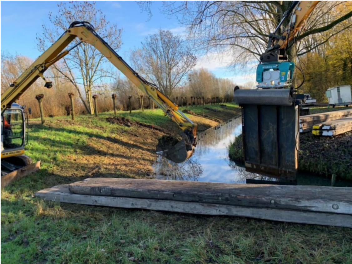
Afbeelding 5.4: Het gebruik van een gaasdrukmachine bij de Merwedewijk, Zuid-Holland
