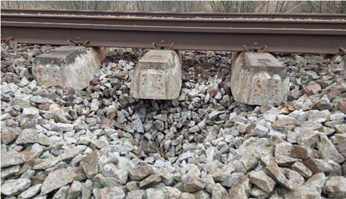
Afbeelding 3.3: verzakking spoorrail als gevolg van bevergraverij, Bron: Beverdilemma bij het spoor | ProRail , februari 2022
