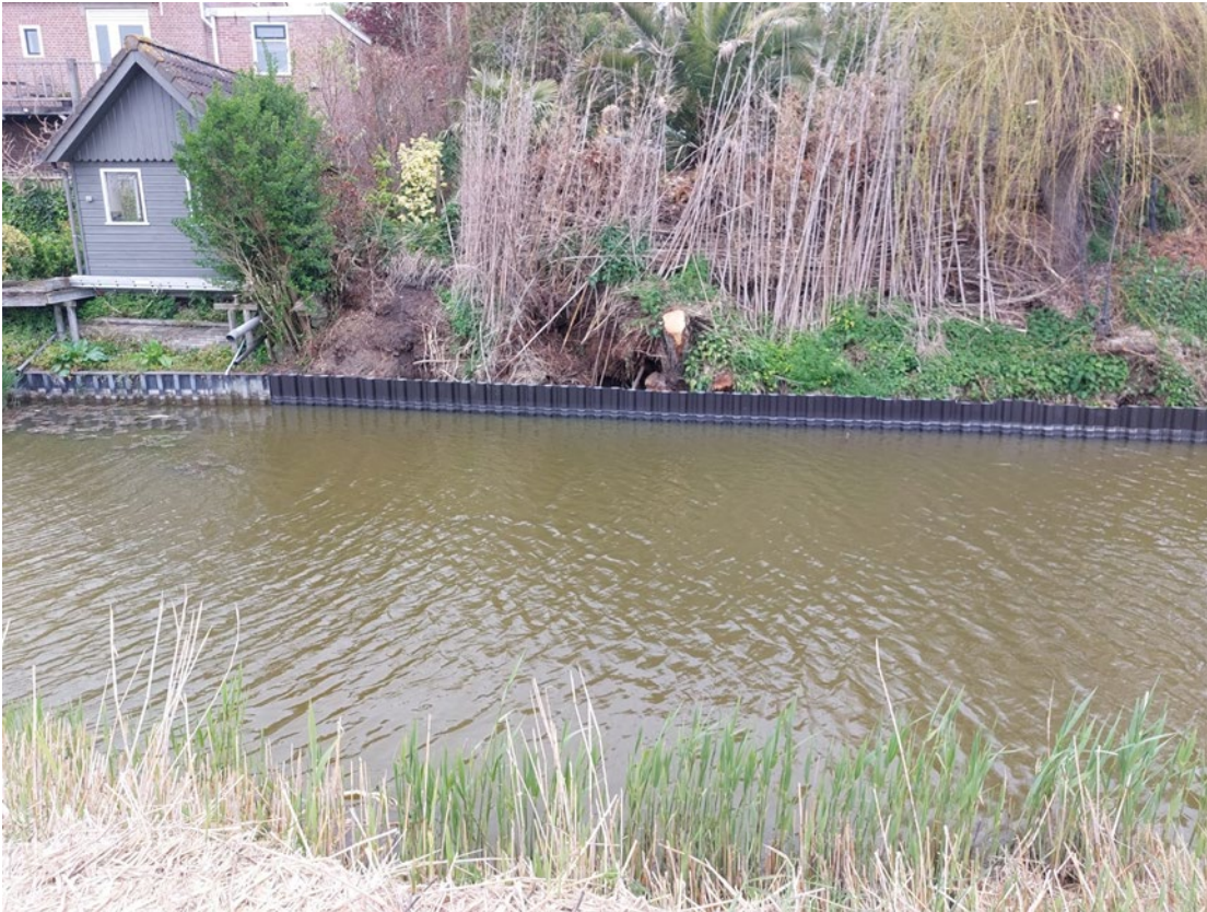
Afbeelding 5.2: Geplaatste damwand in Numansdorp
